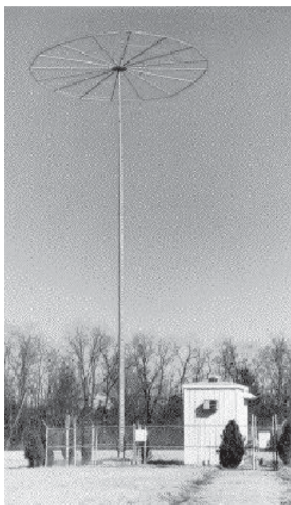
Radio faro NDB de aproximación, con antena tipo sombrilla.
