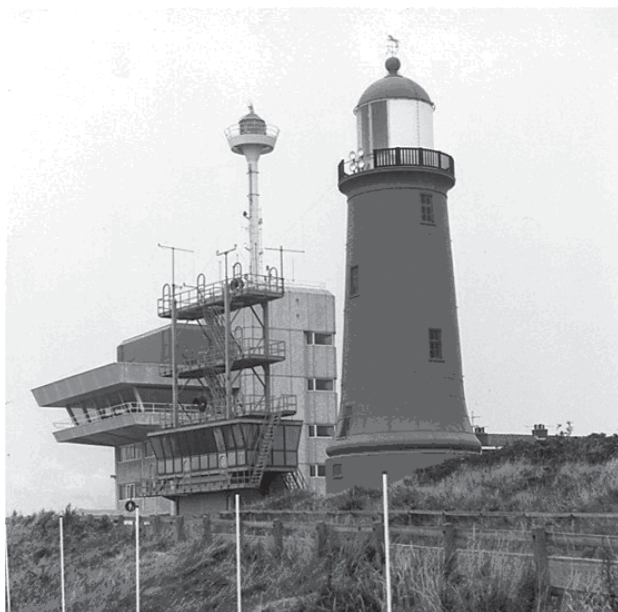
Radio faro marino a la entrada del puerto hacia Ámsterdam.
